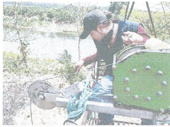
Figura 7. Instalación de torno para aforo líquido y sólido
