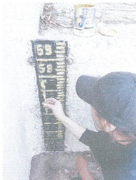
**Figura 26.** Mantenimiento de escalas limnimétricas
