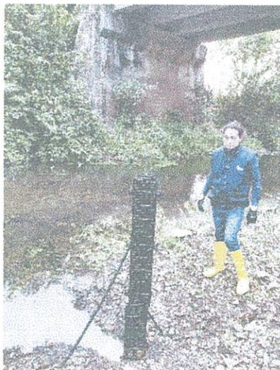
Figura 3. Limpieza y pintura de escala limnimétrica
