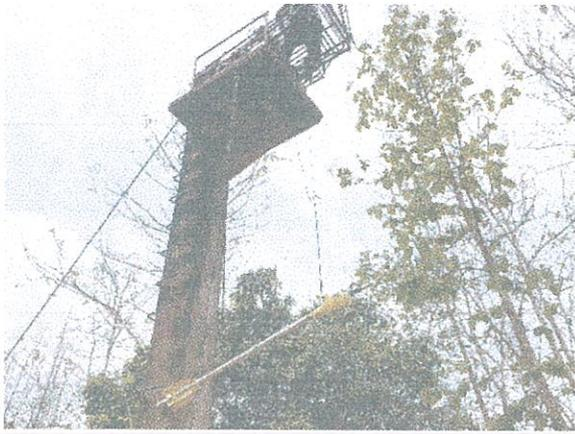
Figura 6. Instalación de escandallo de 25 kg para aforo líquido
