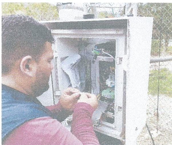
**Figura 35.** Reemplazo de fusible quemado
