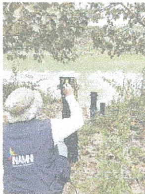
Figura 9. Mantenimiento de escalas limnimétricas
