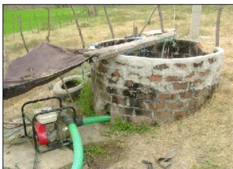
Foto N° 4 Pozo excavado
